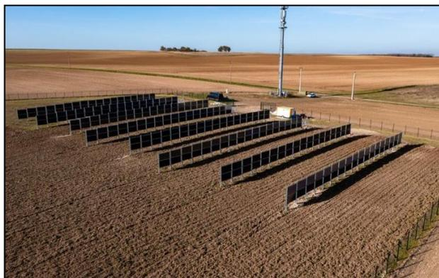
La technologie utilisée allie structures verticales, panneaux photovoltaïques bifaciaux et optimisation de l'emprise au sol pour maximiser la production d'électricité verte lors des pics de consommation électrique. Cette technologie innovante protège également les cultures du vent ou d'une exposition excessive au soleil. Rendez-vous à la moisson pour analyser les résultats de cette expérimentation.
